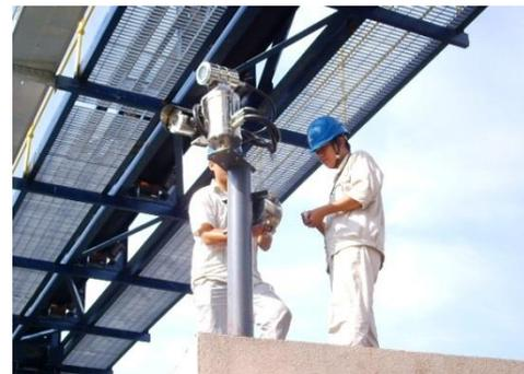
Offshore Pan/Tilt/Zoom Camera com IR A Prova de Explosão
