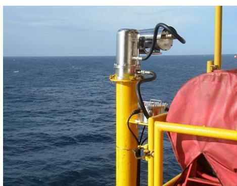
Offshore Pan/Tilt/Zoom Camera A Prova de Explosão
