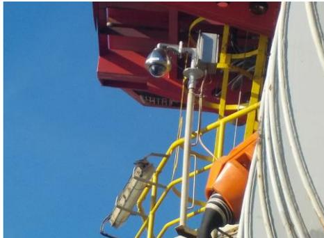
Offshore Speeddome A Prova de Explosão
