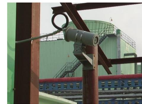
Offshore Câmera A Prova de Explosão
